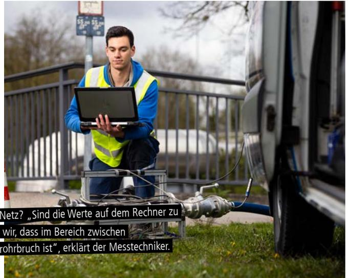
„Fließt die zu erwartende Menge Wasser im Netz? „Sind die Werte auf dem Rechner zu niedrig, dann wissen wir, dass im Bereich zwischen den beiden angeschlossenen Hydranten ein Wasserrohrbruch ist“, erklärt der Messtechniker.“
