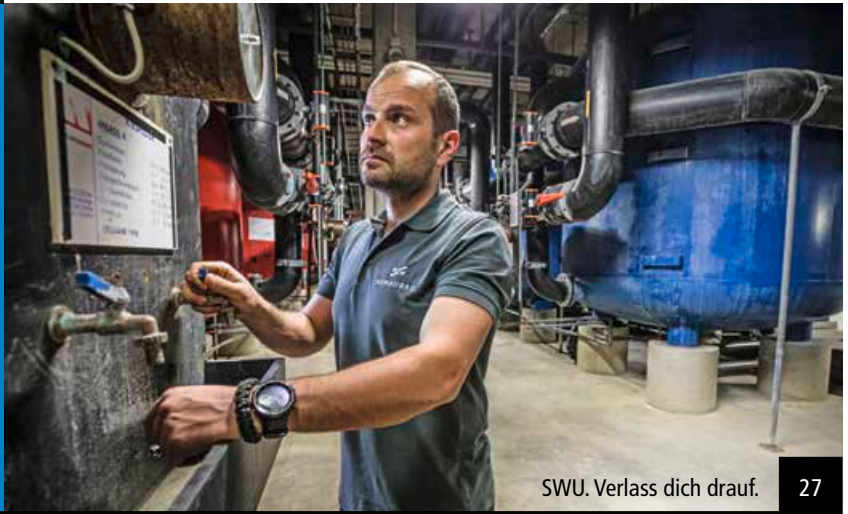
Wichtige Teile des Donaubads liegen unter der Erde: In den riesigen Filteranlagen wird das Wasser gereinigt. Auf dem Foto ist Dragan Prebeg, Mitarbeiter der Technikabteilung, in Aktion
